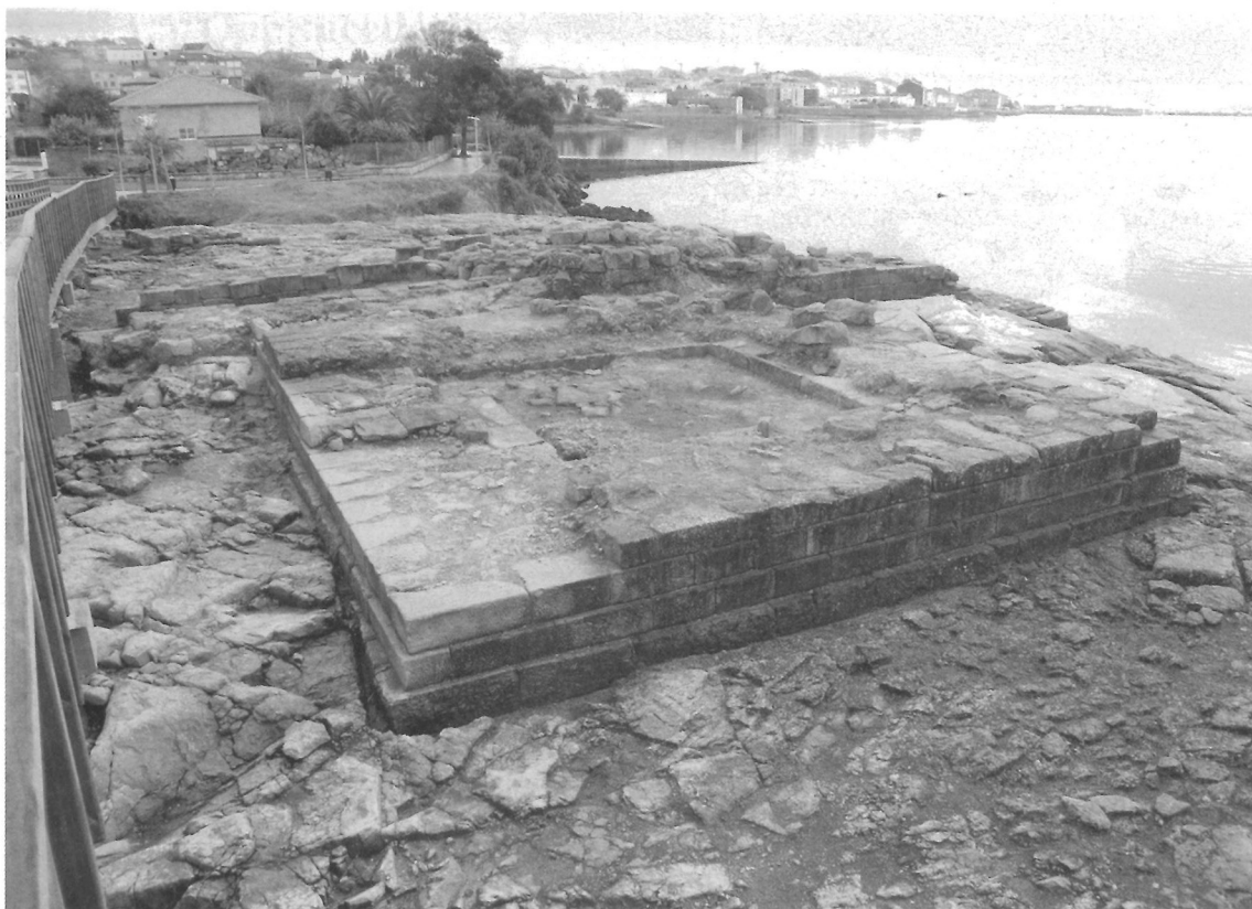
Figura 8: Vista del basamento de la torre
