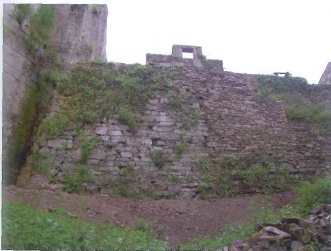
Consolidación de paramentos no lado Leste do mosteiro
